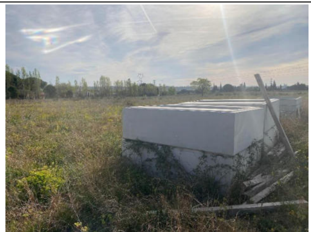
Photographie 4 : Stockage de canalisations en béton
